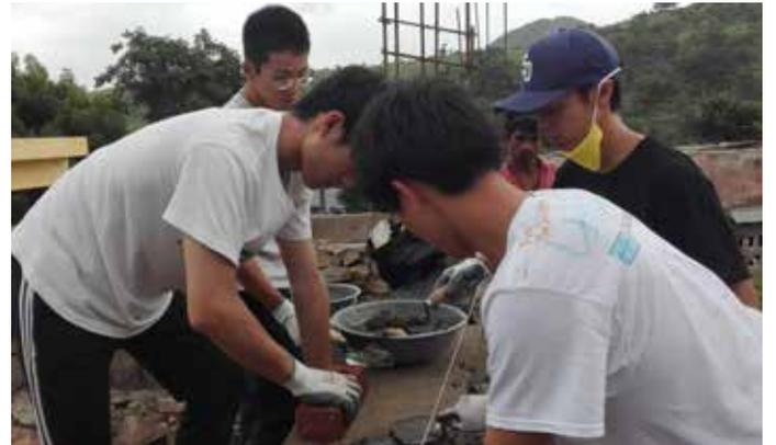
最後に、ロープに沿って並べた煉瓦の間にスコップを使って混ぜたセメントを流し、間を埋める作業をした。この時セメントは水と混ぜてドロドロしたものかと思っていたが、ザラザラした土の感触もよく残っていた。わたしはスコップだけでは隙間にセメントがうまく入ったかどうか分からないので、手袋をした手で触って確認しながら作業をした。作業を進めていく中で、隙間が埋まっていくことが触っても確認できた。
