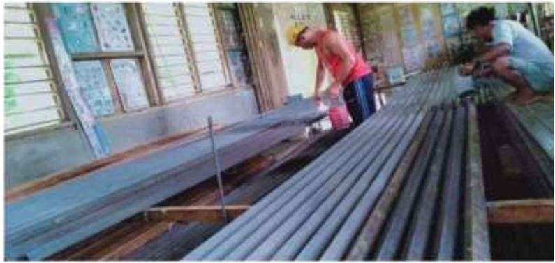
錆びて穴だらけだった屋根の交換準備・防錆処理
