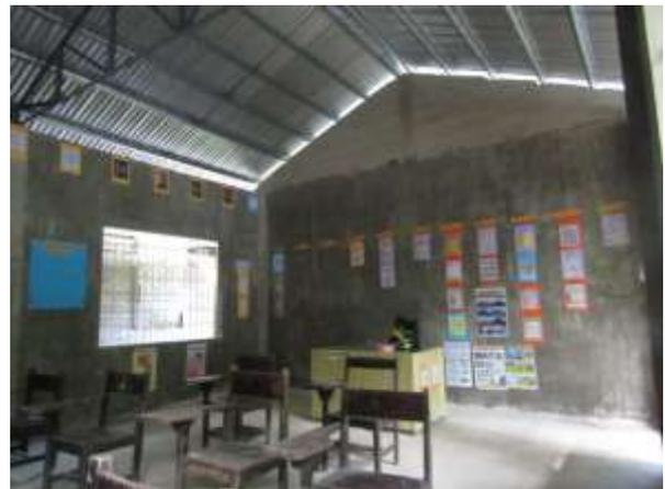
完成した校舎(内装)。旧教室棟で木造だった壁は床と同じコンクリート製へ、錆びて雨漏りが酷かった屋根も防錆処理を施し、丈夫な材質へ変更。黒板部分(写真左)は可動式パーテーション(スライディングウォール)になっており、取り外して隣の教室と部屋を繋げられるようになっている。
